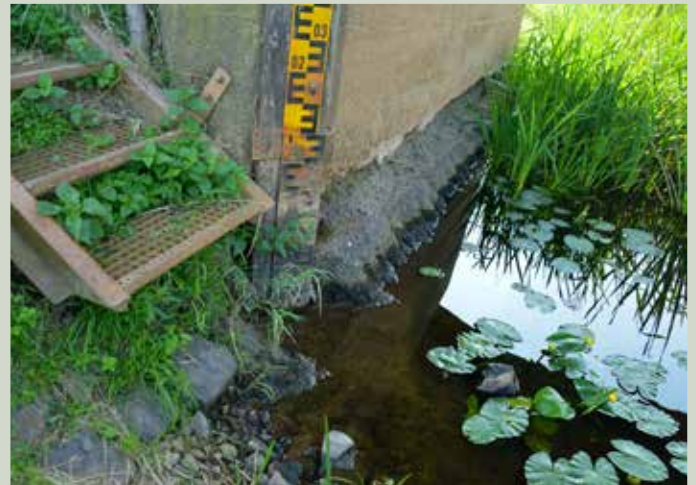
Abb. 10: Betonfraß an Brückenpfeiler
