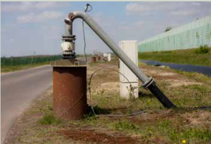
Abb. 12: Grundwasserpumpe
