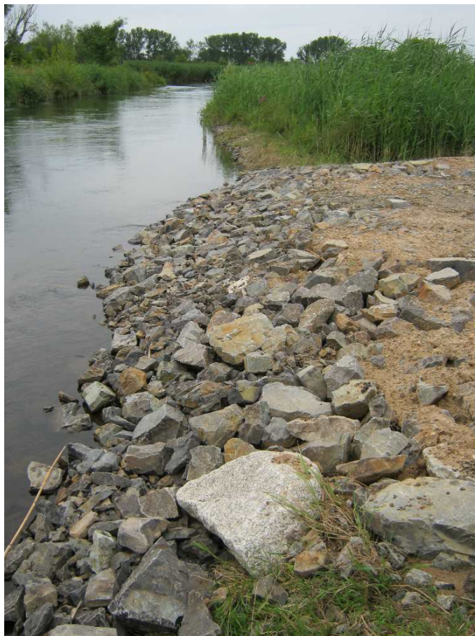
Zustand nach Beseitigung des Bauwerks am 16. Juli 2017
