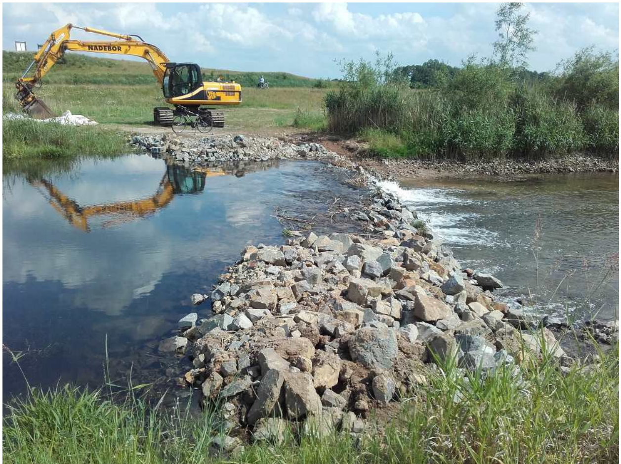
Arbeiten am 5. Juni 2017
