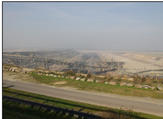
Blick auf die Abraumförderbrücke im Tagebau Jänschwalde
